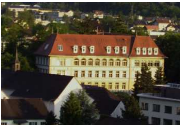
1994 wurde die umgebaute und erweiterte Volksschule Mitte bezogen. (Foto: Thomas Greiner)
