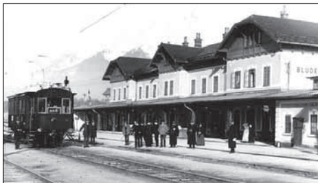
Der Bludenzener Bahnhof in alten Zeiten.
