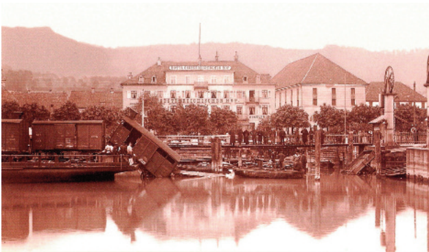
Unfall in der Trajektanlage im Brezgener Hafen, Fotografie von Thaddäus Immler; Vorarlberger Landesmuseum, Inv.-Nr. 4954
