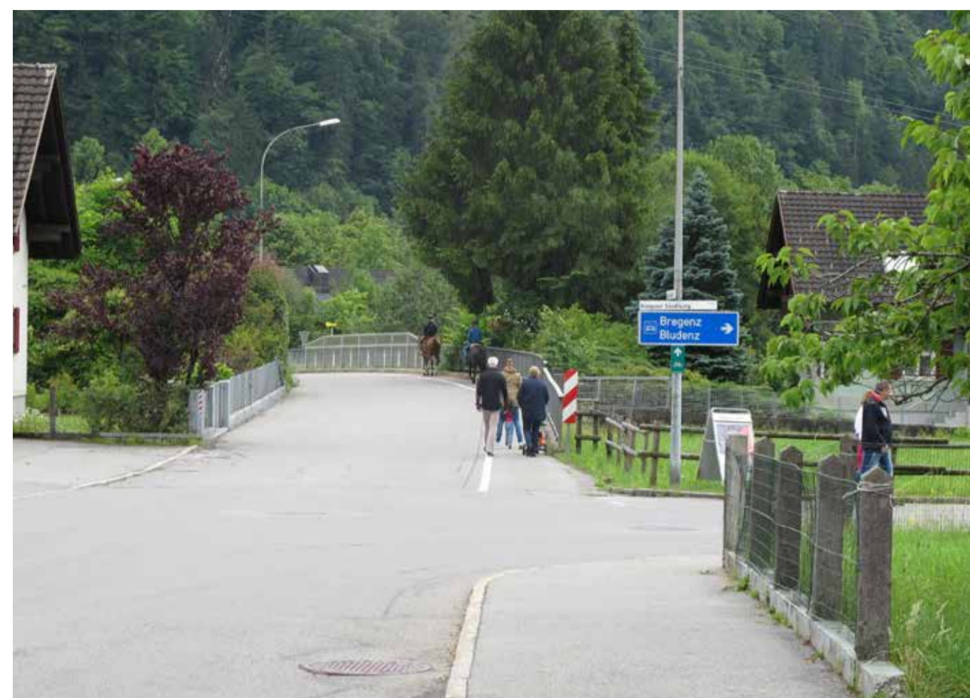
Brücke Verbindung zwischen Stallehr und Bings, Gefahrenstelle für Fußgänger
