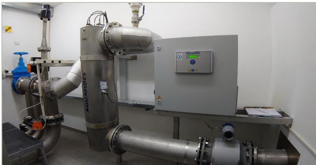
Die UV-Anlage beim Hochbehälter 1 musste durch eine zertifizierte Anlage ersetzt werden.
