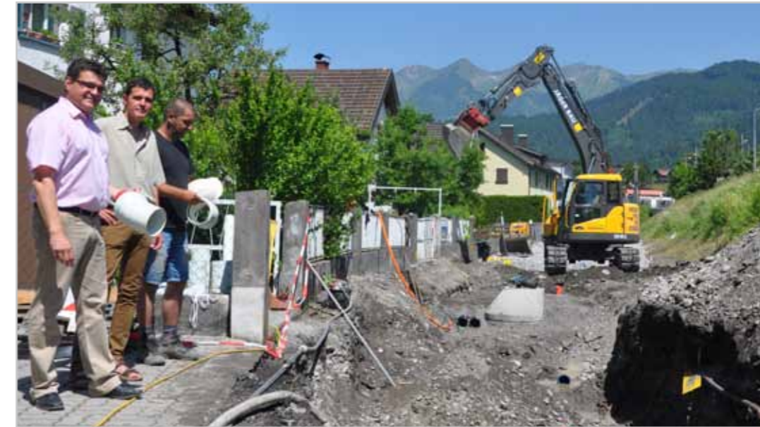
Baustadtrat Arthur Tagwerker, Wasserbauchef Wolfgang Peiker und Polier Werner Hofmann (Firma Jäger) bei der Baustellenbesichtigung.
