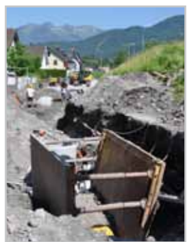
Die Baugrubensicherung stützt die Böschung
