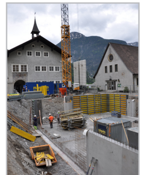
Eines der laufenden Bauprojekte der Stadt Bludenz: der Kindercampus Bings.
