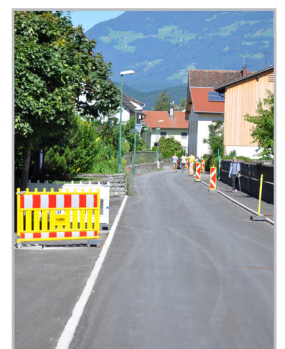
Die Sanierung in Brunnenfeld bringt deutliche Verbesserungen.
