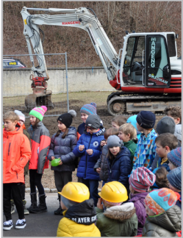
In Bings rollten die Bagger an.
