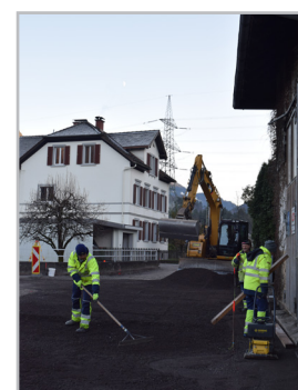
Die Ortsdurchfahrt in Brunnenfeld wird Ende März fertig gestellt.
