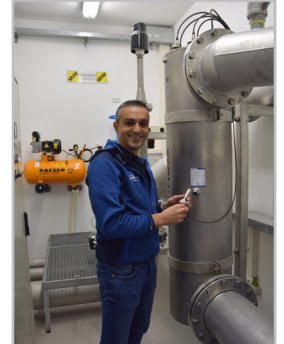
Die UV Desinfektion ist ein rein physikalischer Prozess, dessen natürliche Wirkungsweise von der Sonne abgeschaut wurde.
