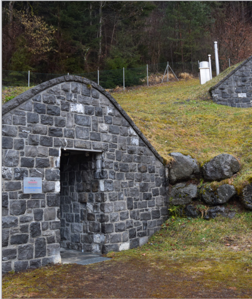
Bereits 1998 wurde die UV-Anlage in Hinterplärsch errichtet.
