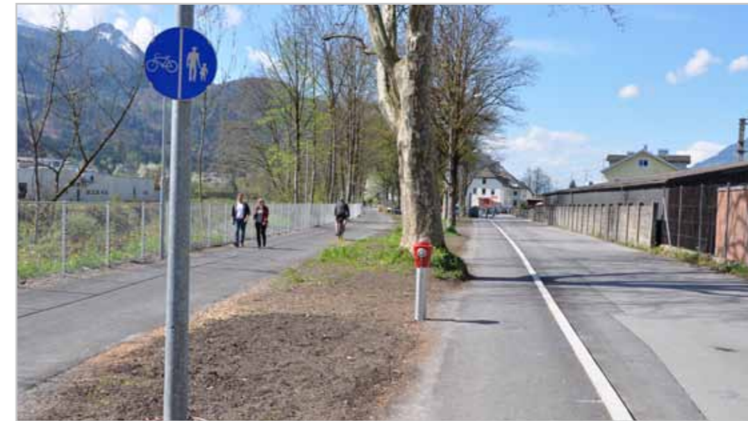
Mit dem Kanalbau in der Mokry wurden auch Gehsteig und Radweg realisiert. Das Land Vorarlberg hat den Bau ebenfalls gefördert.
