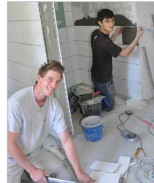
Die Umbauarbeiten in der Volksschule St. Peter laufen auf Hochtouren.
