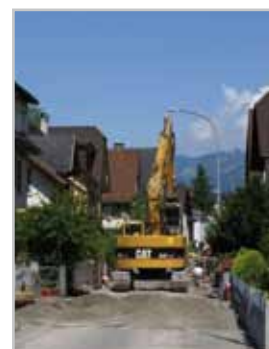
Eine der vielen Kanalbaustellen, die erledigt wurden.
