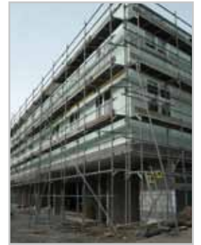
Die Bauarbeiten beim neuen Rettungszentrum schreiten zügig voran.
