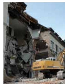
Das Krankenhaus wird umgebaut.
