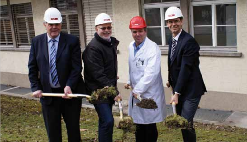
Offizieller Spatenstich: Bürgermeister Mandi Katzenmayer, Vizebürgermeister Peter Ritter, Chefarzt Matthias Scheyer und Landesstatthalter Markus Wallner.
