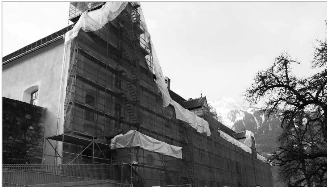
Gut sichtbar ist nun die Außensanierung von St. Pete. Wesentlich mehr Arbeit war im Innenbereich des Klosters, das sich nach der Sanierung auch der Bevölkerung öffnet.
