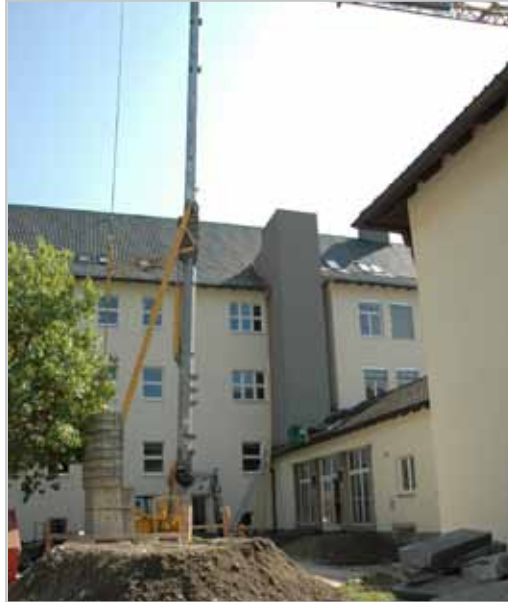
Der Zwischentrakt der Bludener Mittelschule ist eine Großbaustelle.
