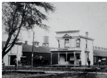
Blacksburg in Virginia - eines der Auswandererziele
