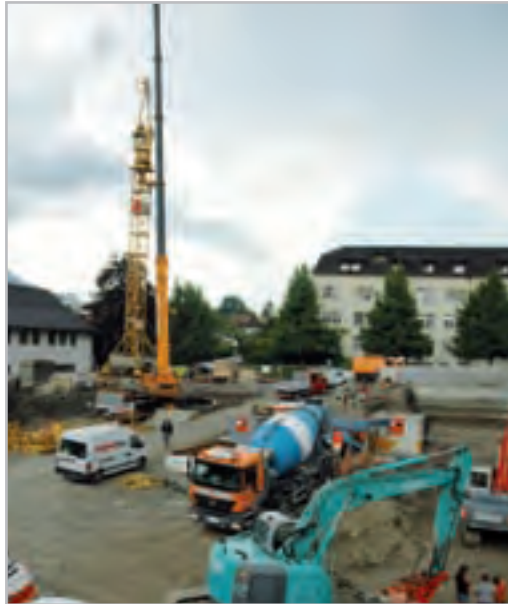
Eine Großbaustelle ist derzeit der ehemalige Krankenhausparkplatz.
