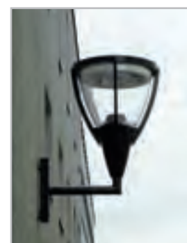
Die neuen Beleuchtungskörper in der Pulverturmstraße
